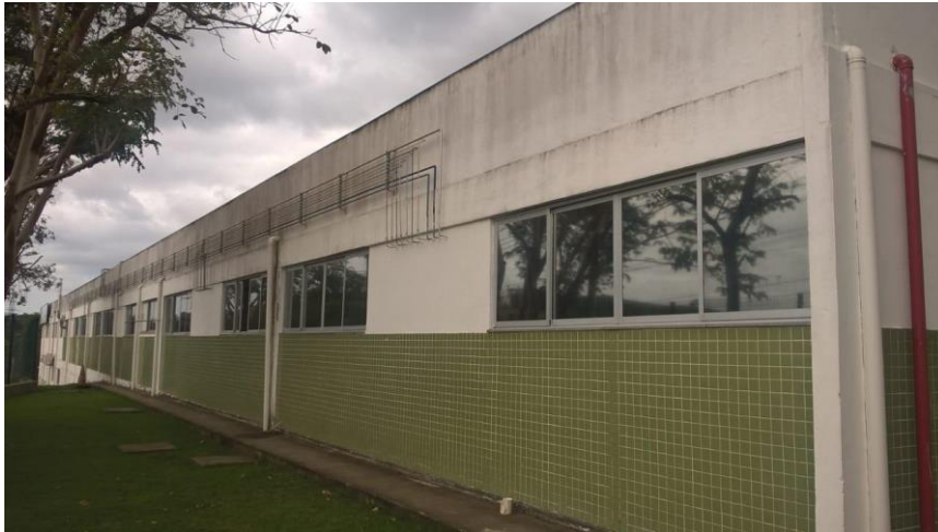
Fachada Bloco C – Norte
