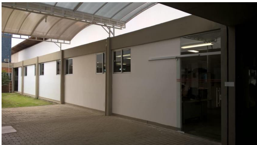
Fachada da Biblioteca
