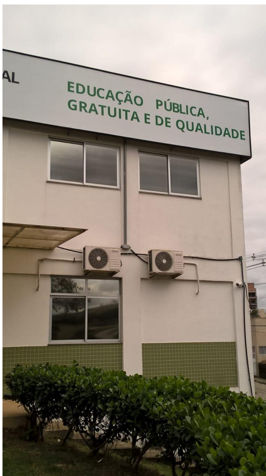
Fachada Bloco C – Fundos
