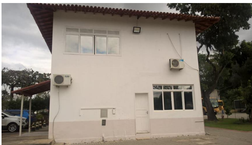
Bloco A – fachada lateral
