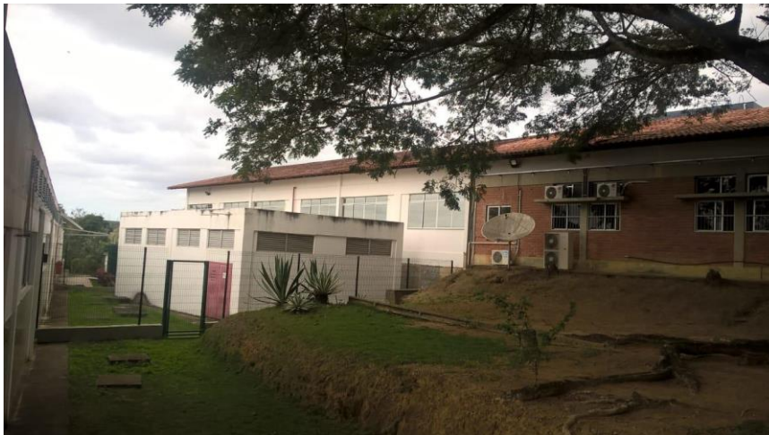
Fachada Bloco D – Norte
