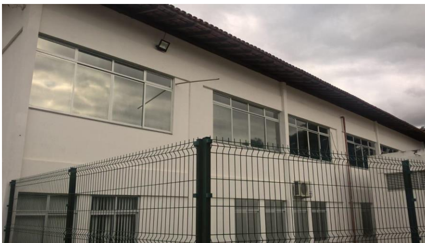
Fachada Bloco D – Norte
